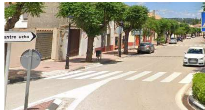
Exemple de pas per als vianants comú amb gual. Entrada al centre urbà des de la rotonda que connecta el Passeig d'Ombria amb l'Avinguda Comte Salvaterra d'Àlava.
