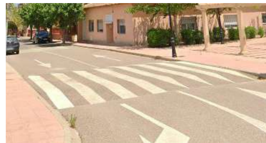
Exemple de pas per als vianants en badán amb gual. Encreuament Carrer Josep Renau amb Passeig d'Ombria.
